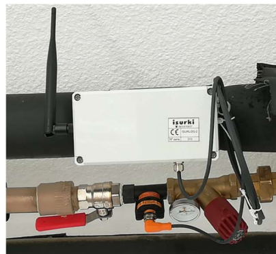
ISURLOG-LR registrando caudal y temperatura en una red ACS con enlace LoRa
